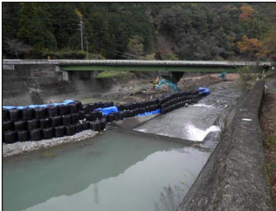
他社施工仮締切(興津川上流)
