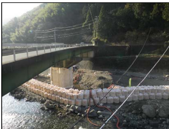
過去の当社施工仮締切(興津川上流)
