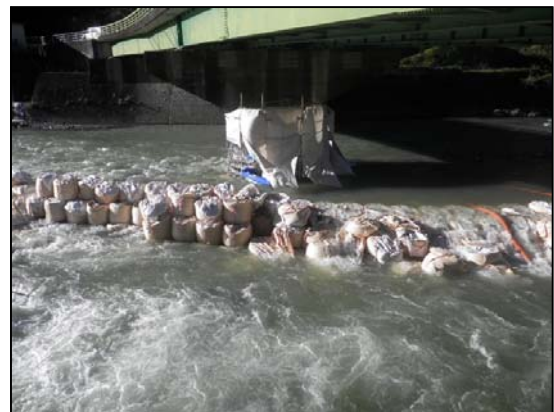
増水による流出(興津川上流)
