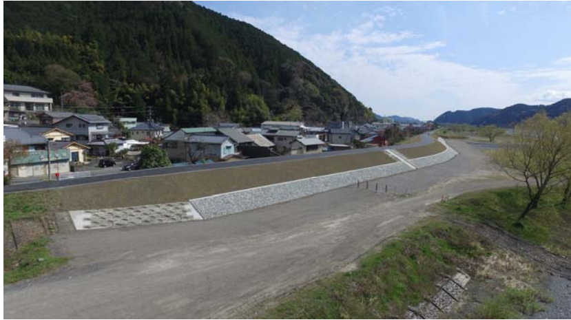
写真-5 完成写真
