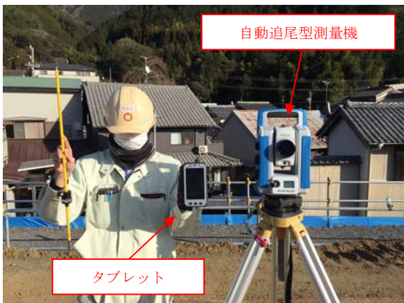
写真-2 自動追尾型測量機とタブレット
