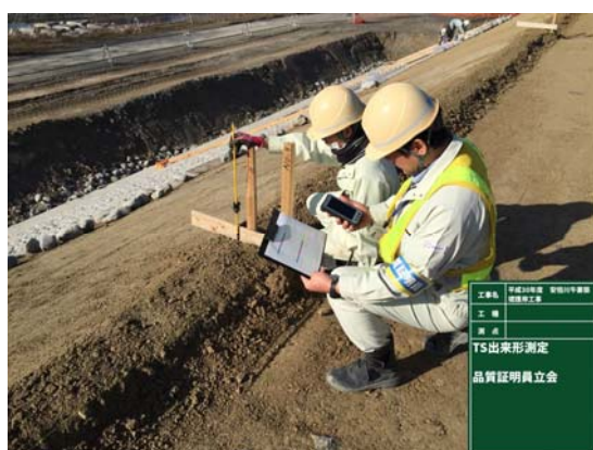
写真-4 TS 出来形測定
