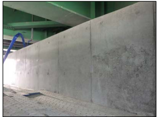
写真-4 コンクリート打設後
