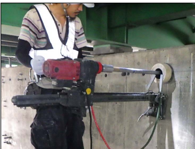
写真-9 コア削孔機
