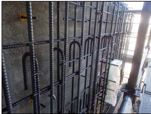
写真-3 配筋状況
