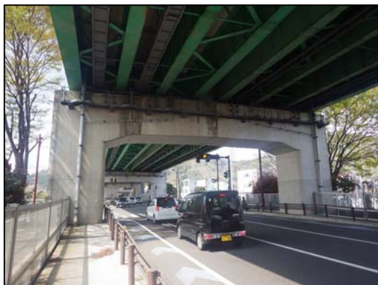
写真-1 現場周辺状況
