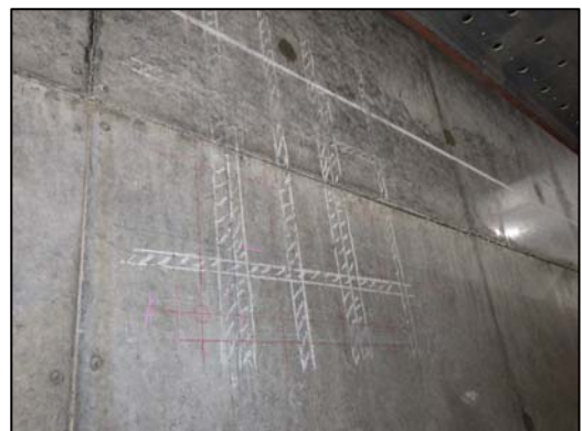
写真-6 マーキング完了
