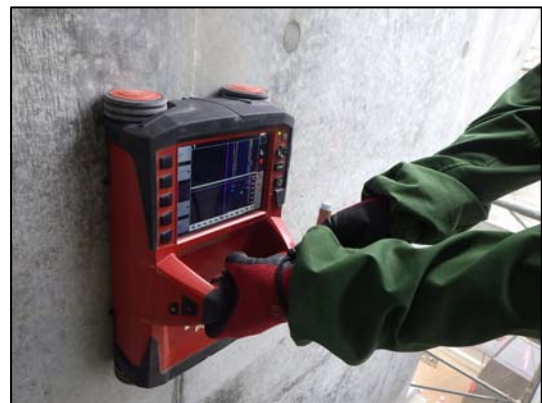
写真-2 鉄筋探査状況
