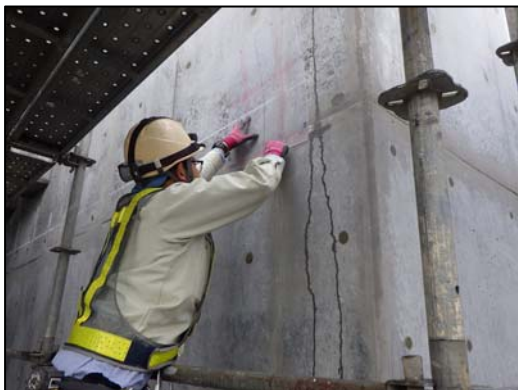
写真-5 マーキング状況
