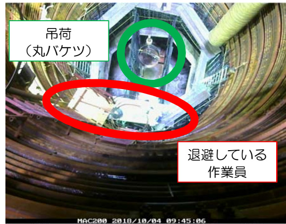
『半月板直下に退避する作業員』
