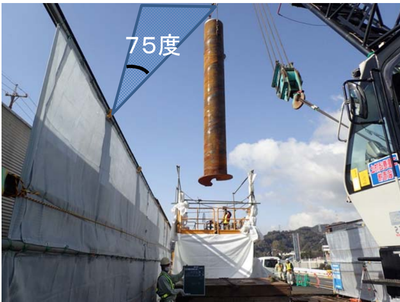
鋼管杭打設状況
