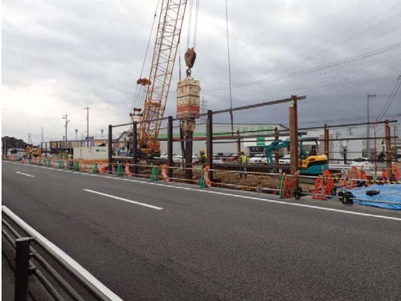
鋼矢板打設状況
