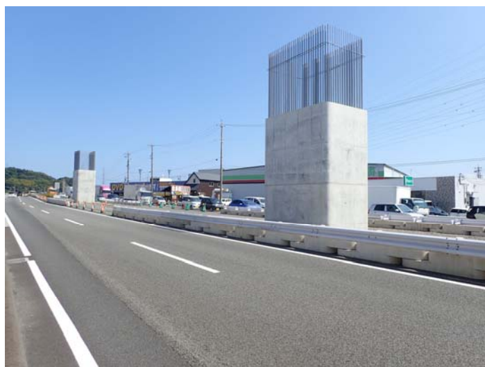
完成状況全景
