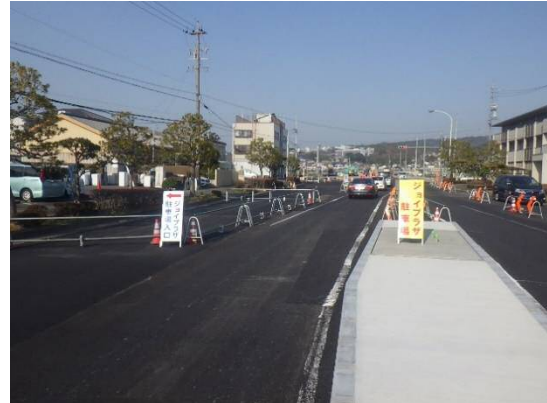
写4・施工中規制状況 (工事起点側)
