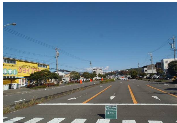
写2・施工前現況道路《中央分離帯》 (工事起点側)
