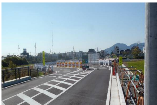
写1・施工前現況道路《大きく蛇行》 (橋梁新設西側)
