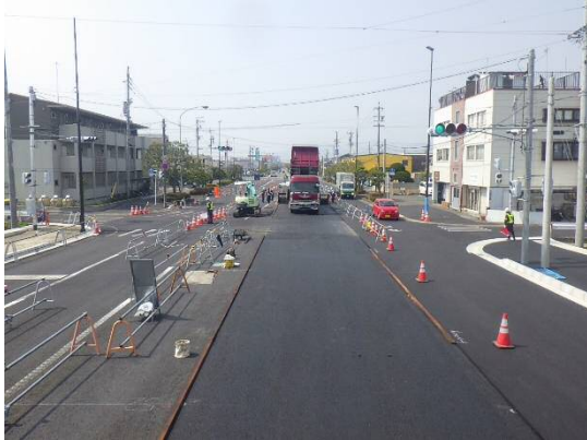
写3・施工中規制状況 (交差点付近)
