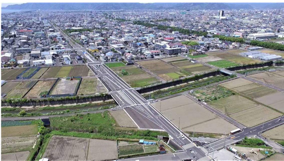
完 成 （工事終点側から工事起点側を望む）
