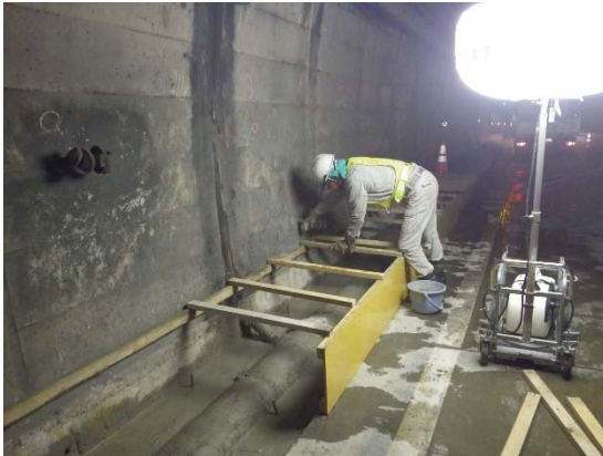
監査路仮復旧状況
