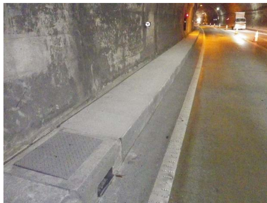
監査路復旧完了
