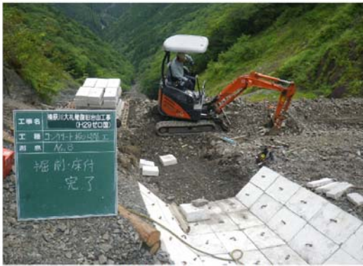
【掘削床付状況】
