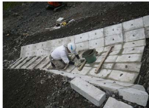
【目地仕上げ状況】
