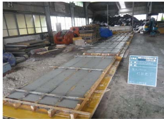
【コンクリート打設】
