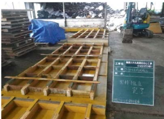
【型枠組立状況】
