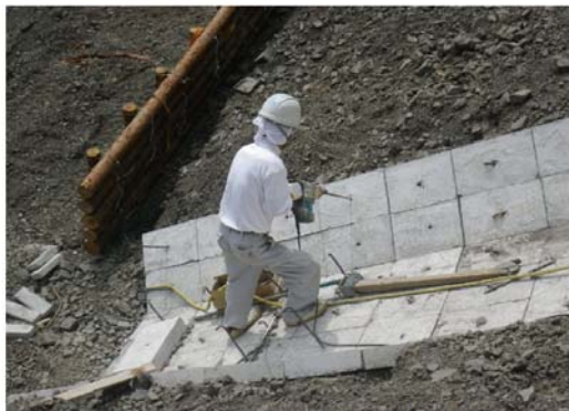
【アンカーピン削孔状況】
