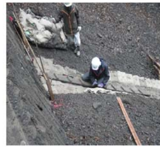
【設置状況(袖部)】
