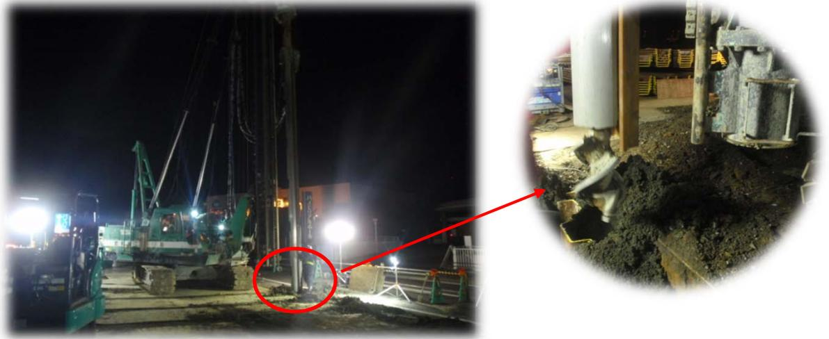
夜間作業により、仮設土留（鋼矢板）・仮設防護柵施工
