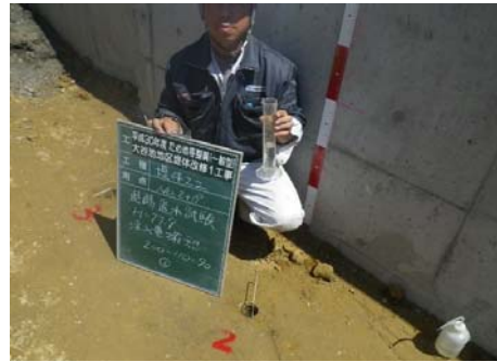
現場透水試験
