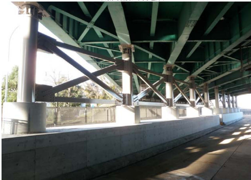
耐震補強部完成
