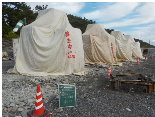
養生状況 (コマシート使用)
