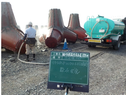
打設前型枠への散水状況
