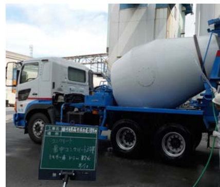
生コン車 ドラムへの散水状況
