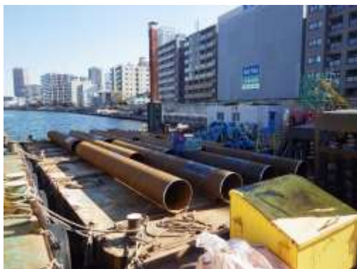
No.2 台船を使用したヤードの確保
