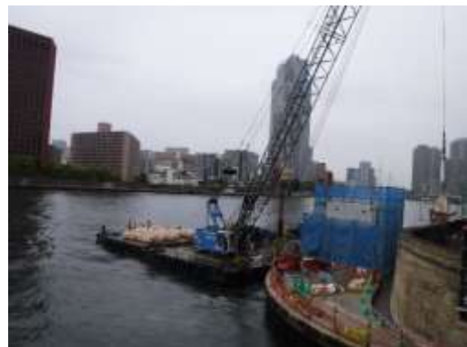
No.2 台船を使用したヤードの確保
