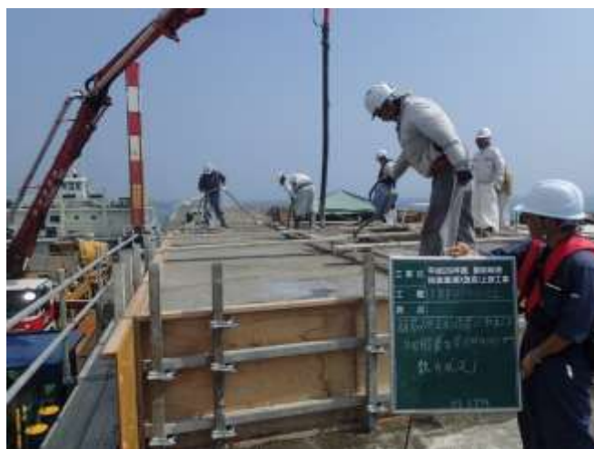
写真-2 被膜養生剤散布状況
