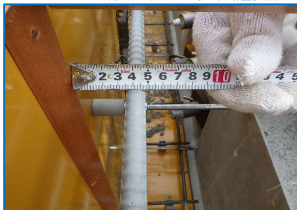
生コンクリート打設前鉄筋かぶり厚・防錆塗装確認
