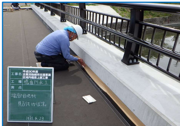
端部目地材2回目貼付け状況
