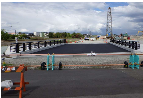
アスファルト舗装完了
