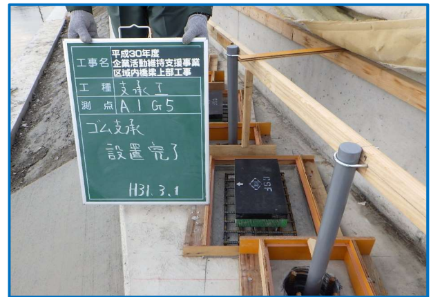
ゴム支承設置完了
