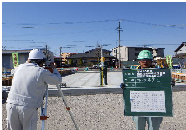
伸縮装置出来形測定状況
