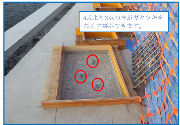
ゴム支承設置前
