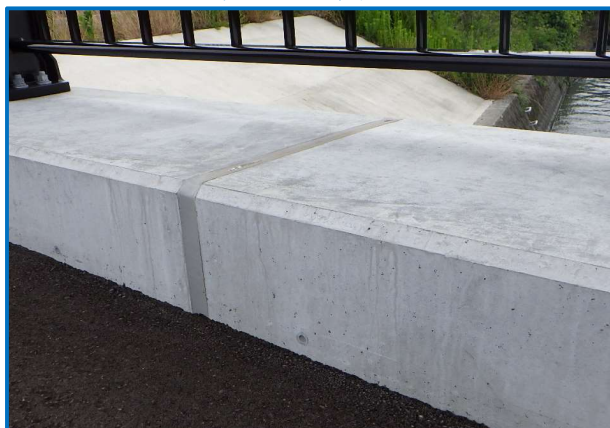
誘発目地設置完了
