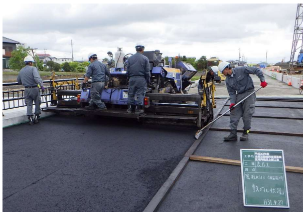
アスファルト舗装施工状況
