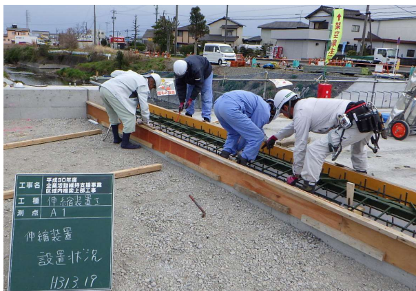
伸縮装置設置状況
