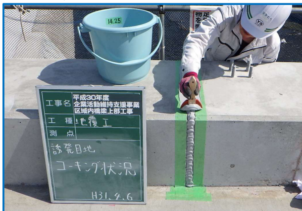
誘発目地シリコン系樹脂充填状況
