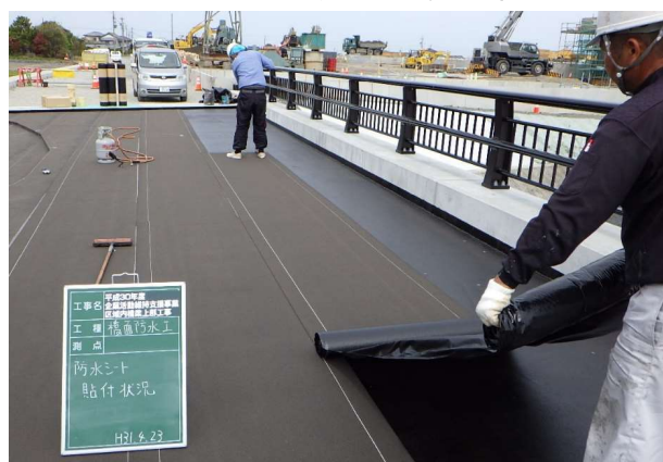
プライマー塗布後シート貼付け状況
