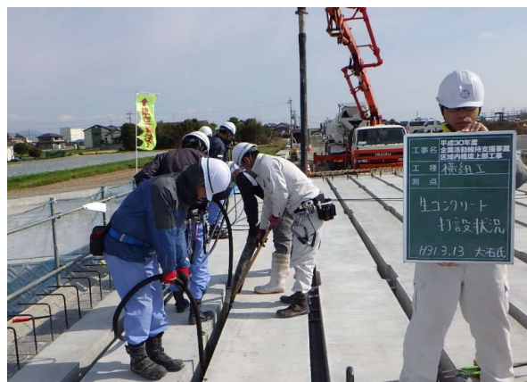
間詰めコンクリート打設状況
