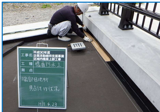
端部目地材1回目貼付け状況
