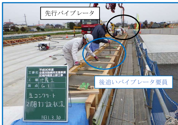
生コンクリート打設状況
