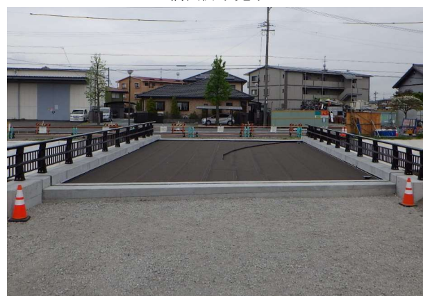
橋面防水完了
