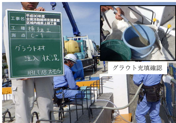
横締緊張後グラウト注入状況
