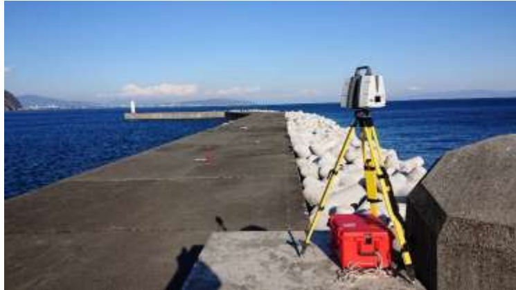
レーザースキャナー計測状況
