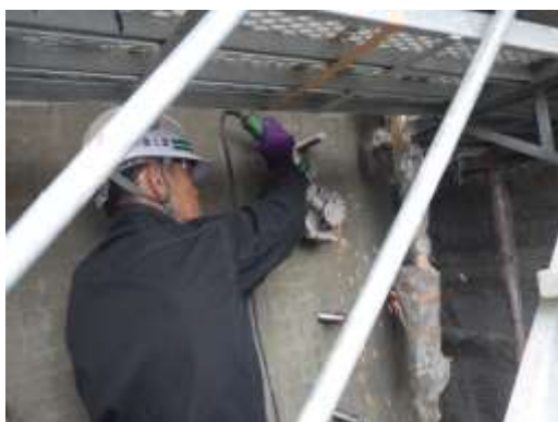
現場切断状況
