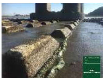
濁水防止マット設置状況
