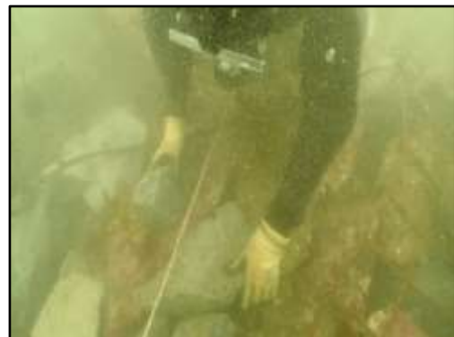
〈丁張りに基づき間詰石均し作業を施工〉
