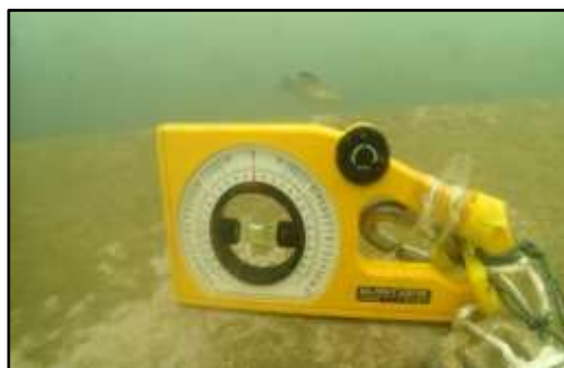
〈前日の据付箇所を水平器にて確認〉
