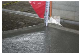
再振動後の沈み込み
