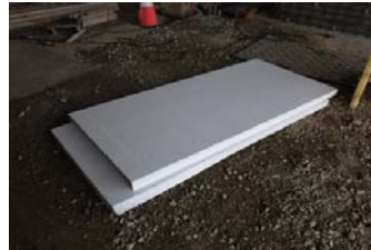
透水シート型枠に設置
