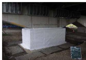
塗膜養生(散水あり)
