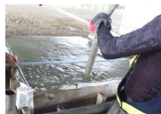
再振動による気泡の上昇
