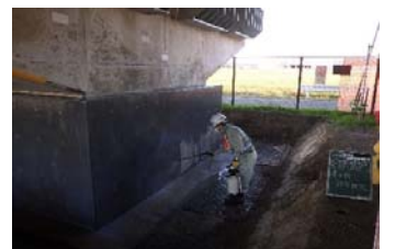
塗膜養生材散布
