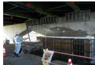
散水養生風景
