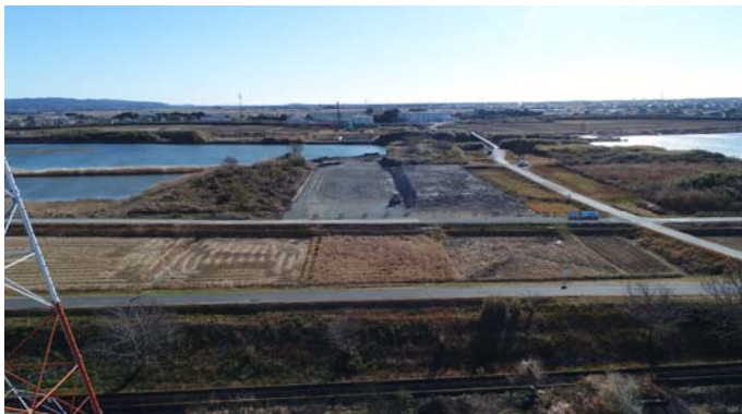
A2橋台側からP5橋脚側を望む
