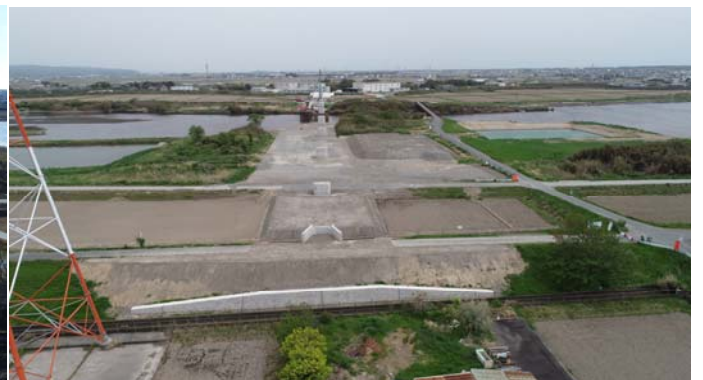
A2橋台側からP5橋脚側を望む
