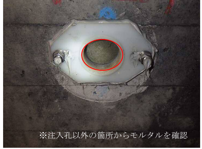
写真 - 9 充填完了確認(近景)
