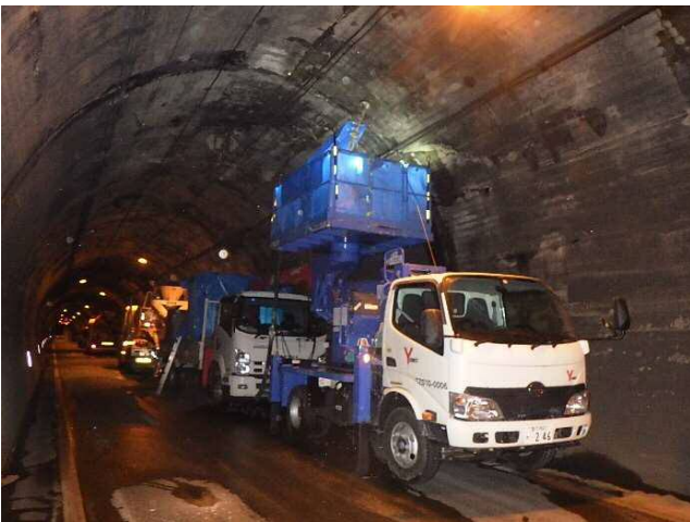
写真 - 4 打設状況(全景)
