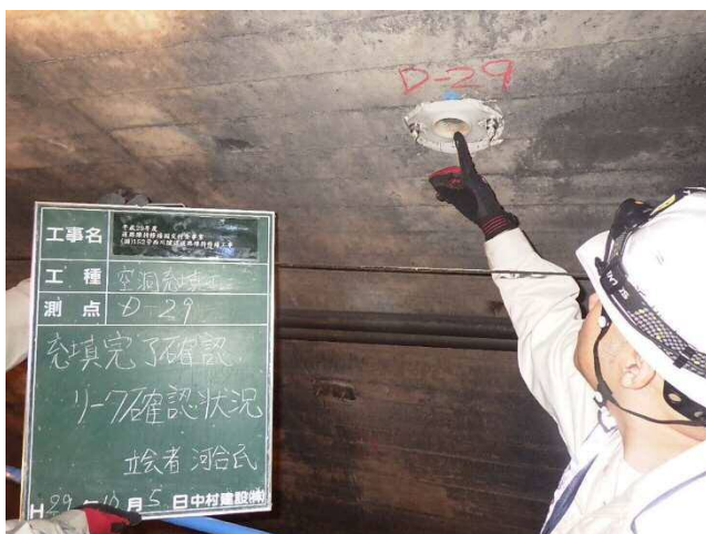
写真 - 8 充填完了確認(現地立会確認)
