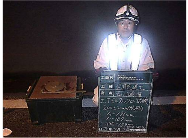
写真 - 3 フロー試験(現地立会確認)
