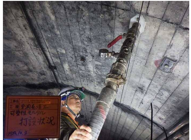
写真 - 5 打設状況(近景)
