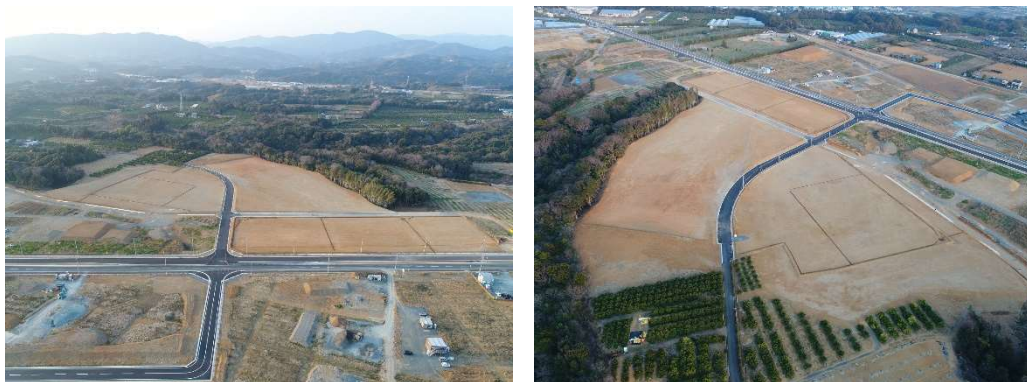
写真-7 完成写真(全景)
