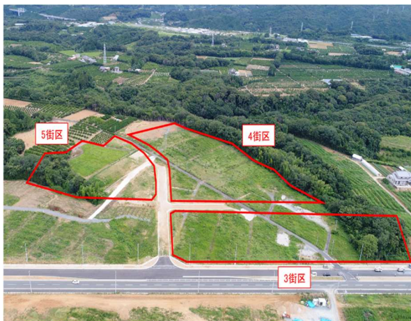
写真-1 工事施工箇所(全景)
