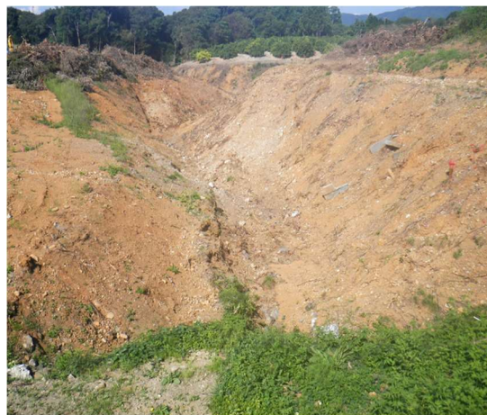
写真-2 伐採完了時
