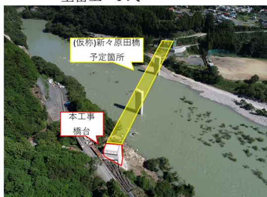
写真－１ 工事施工箇所
