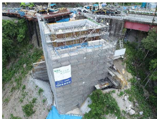
写真－２ 工事施工状況
