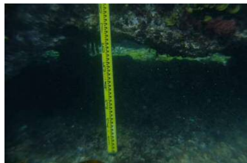
橋脚欠損部の状況
