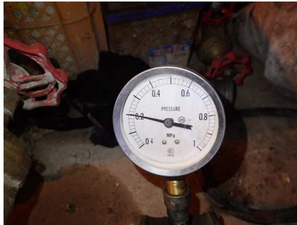
注入圧力確認(写真-3)
