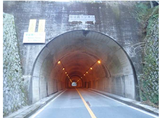
トンネル外観
