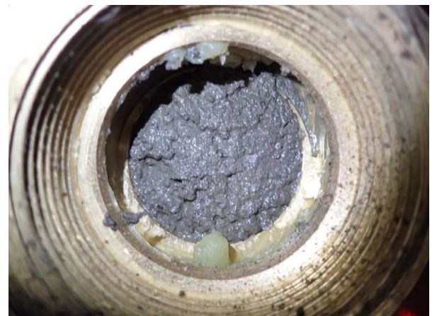
リーク確認状況(写真-6)
