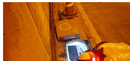
閉塞処置完了(写真-3)
