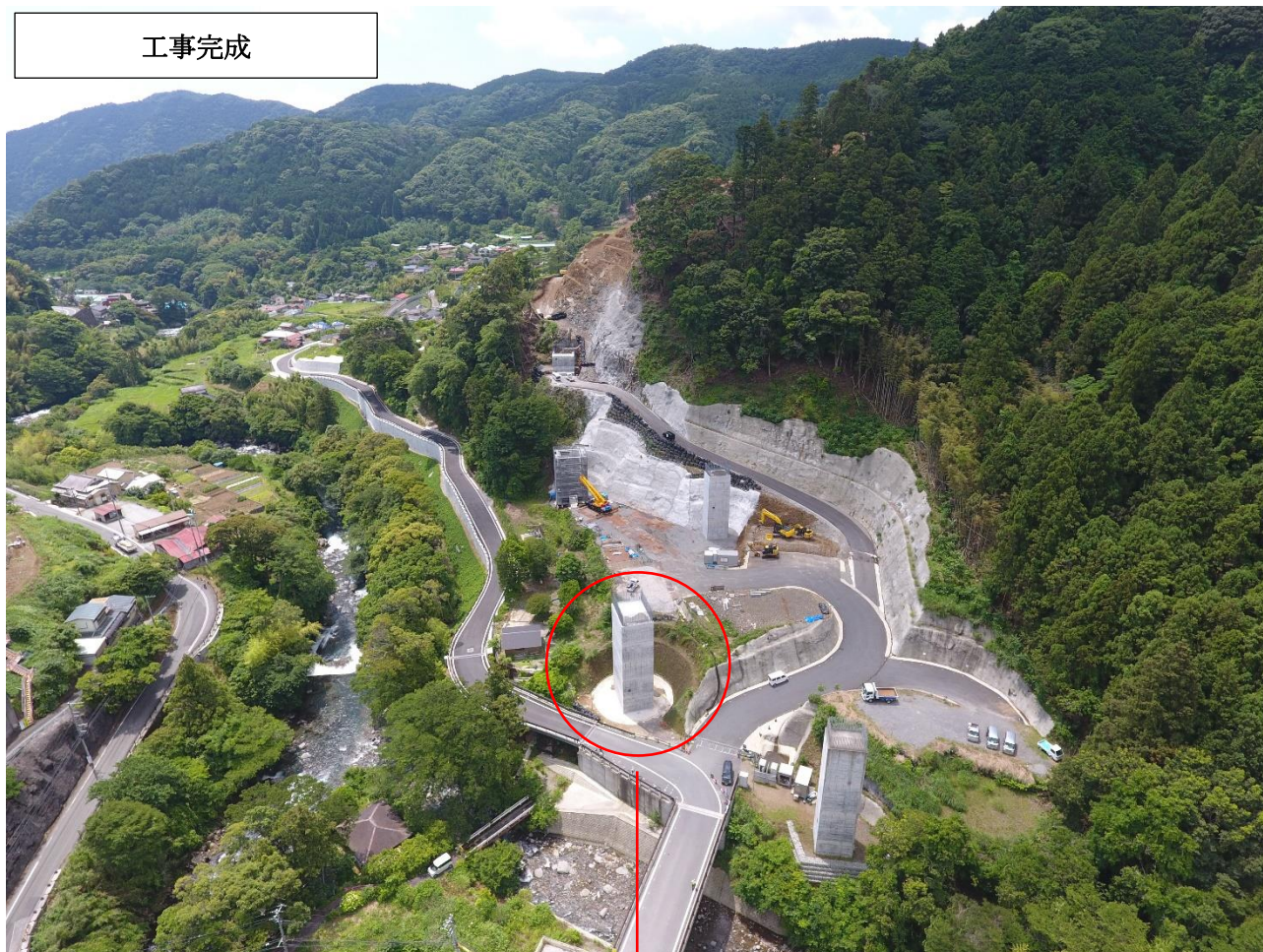
AP4 橋脚完成
