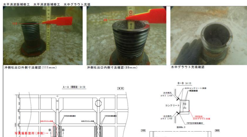
グラウト充填完了時の写真
