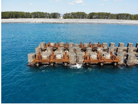
第一離岸堤（PBS）完成
