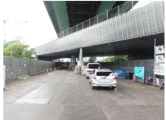
吊り足場架設後 (足場の内部は板張り・シート張り)
