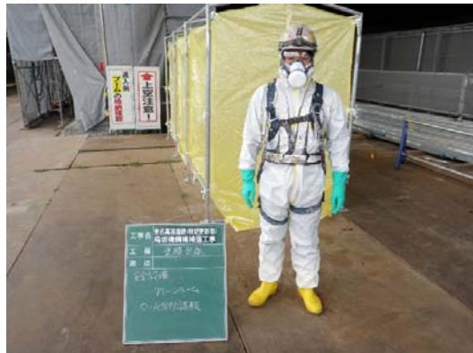
塗膜剥離作業から塗装まで一連の作業は化学防護服・面体・手袋・長靴を着用する。
