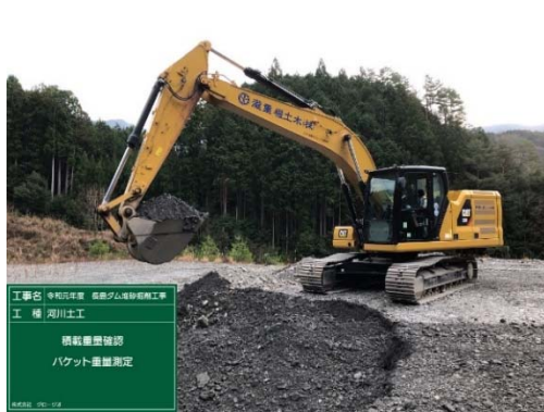
バケット土砂重量測定（ペイロードによる）
