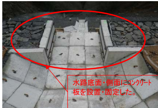
【鋼製かご枠土留水路部コンクリート板設置】
