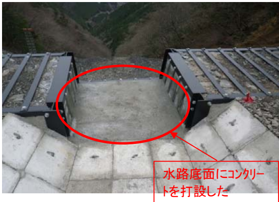
【鋼製枠土留水路部コンクリート打設】
