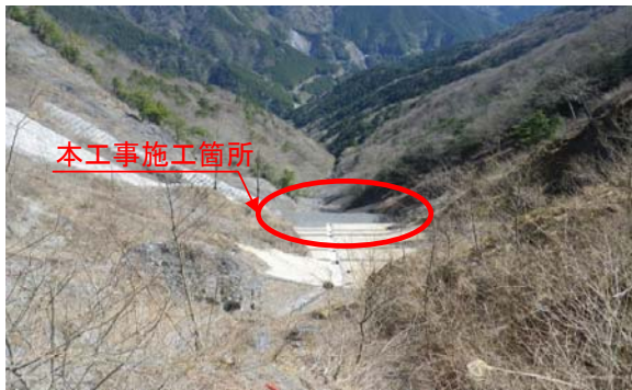
林道上より崩下を望む
