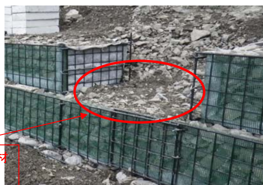
【鋼製かご枠土留水路部】
