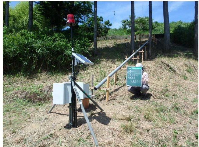
伸縮計警報装置設置状況
