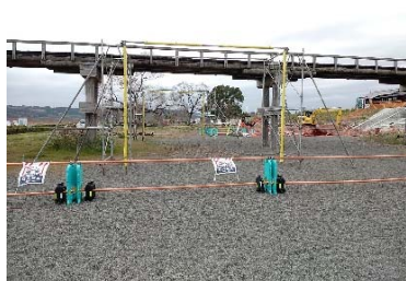
高さ制限ゲート設置
