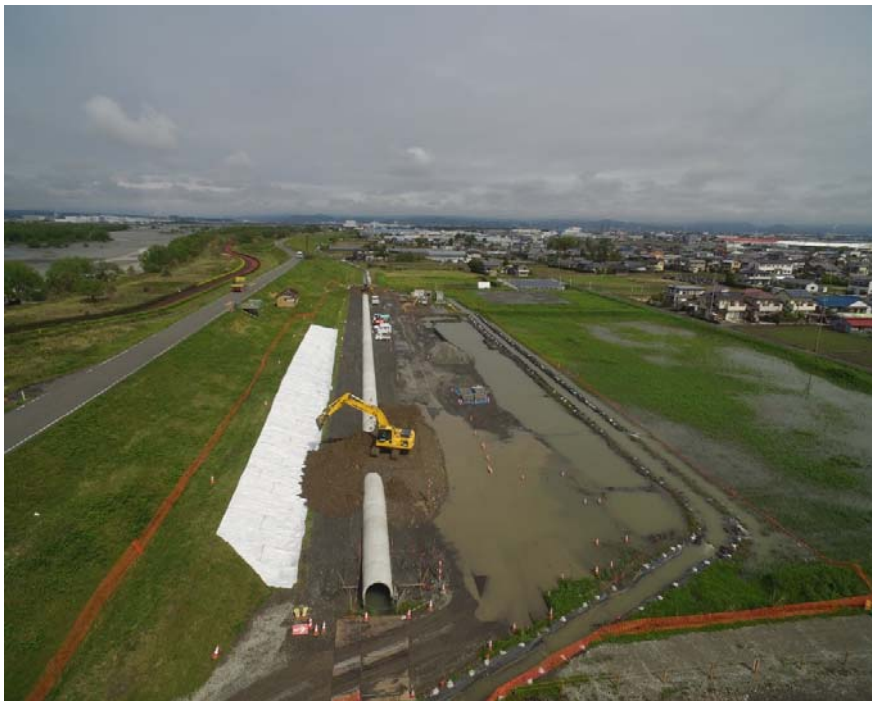
増水時に水路があふれた状況
