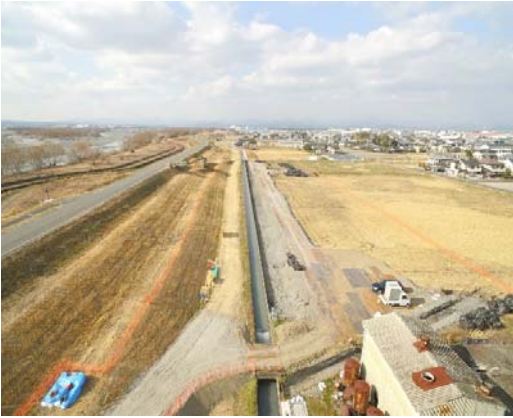
仮水路作成状況
