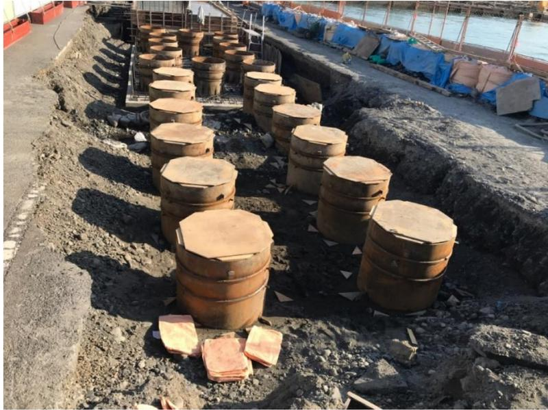
コンパネ 2 枚設置、角切断完了状況。
