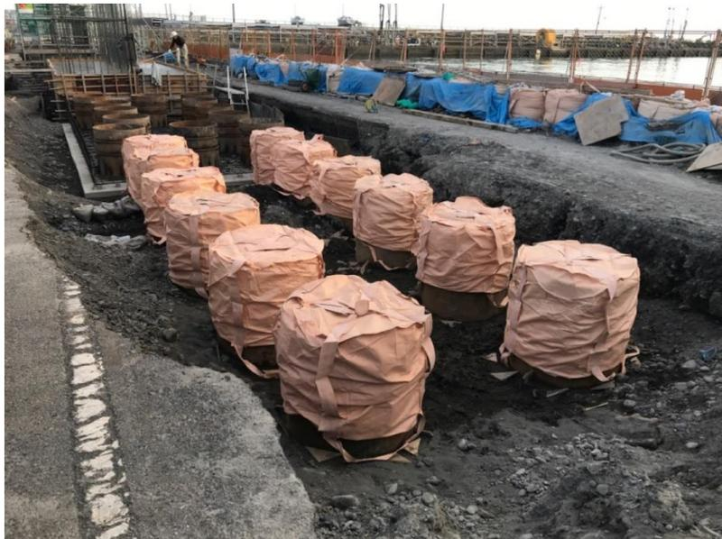
大型土嚢にて覆う事により隙間からの土砂などの流入を防ぎます。
