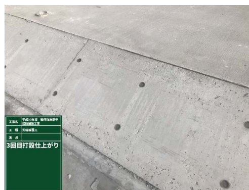
3 回目仕上がり状況
