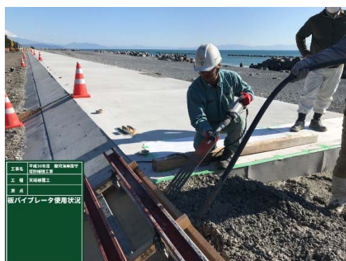
板バイブレータ使用状況
