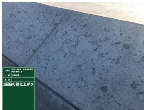
1 回目仕上がり状況
