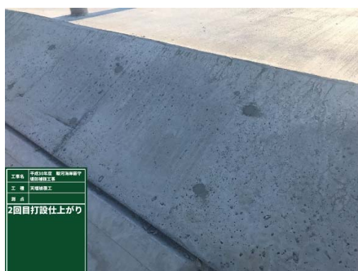
2 回目仕上がり状況
