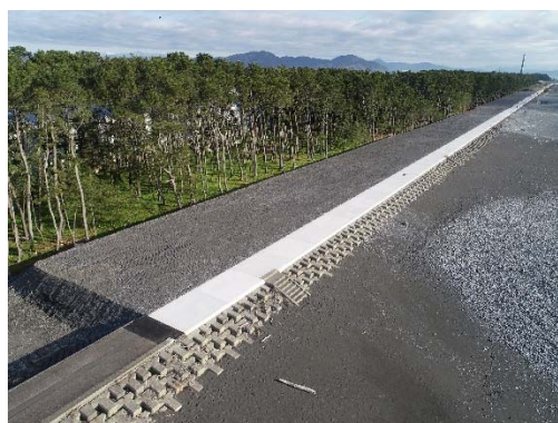
工事終点部より
