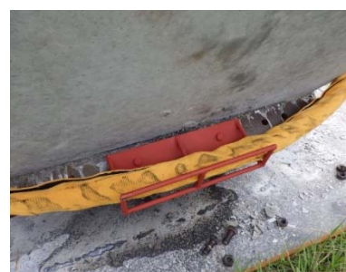
< 玉掛けワイヤー設置状況 >
