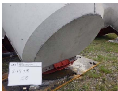
< 専用治具設置状況 >
