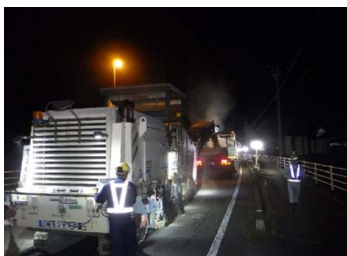
【ヴィルトゲン路面切削機による作業状況】
