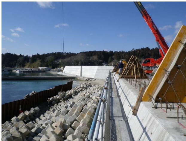
・ブロック据付作業状況
