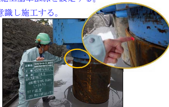
パイルレーザー使用状況
