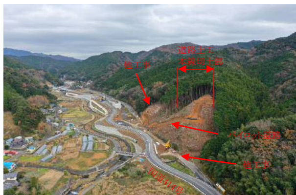
下田側より撮影 （急勾配の切土部と他工事・国道414号線）
