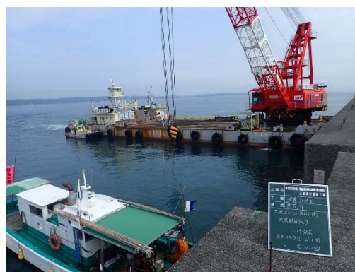
被覆・根固め工 施工状況
