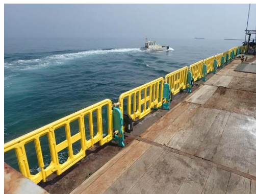
(2) 転落防止の安全柵設置
