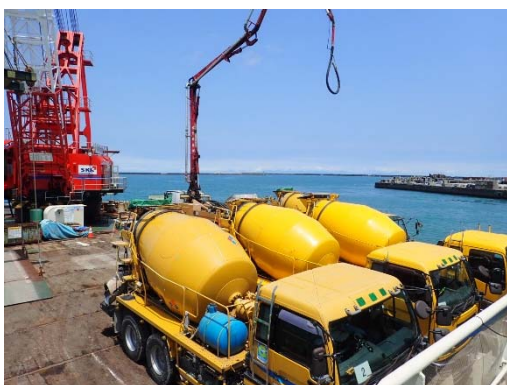
ポンプ車・生コン車積載状況
