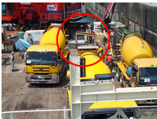
ポンプ車のアウトリガー使用徹底
