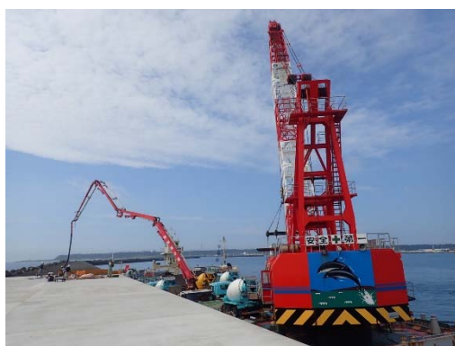
上部工 施工状況
