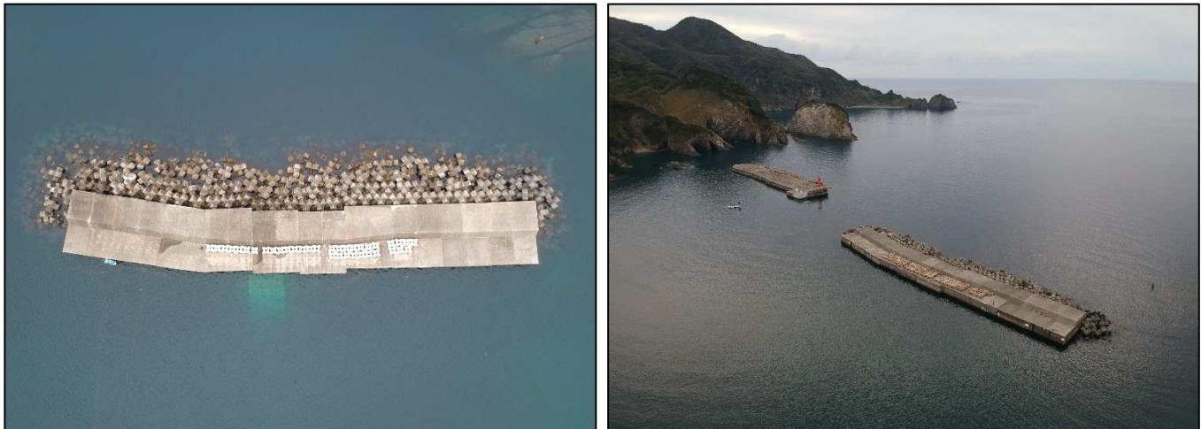
写真管理においてドローンを使用し、ブロック据付後の全体的な見栄えや、防波堤上へ仮置きしたブロックの個数など、従来では分かりにくかった写真を上空から撮影することで一目瞭然となり、現場写真に活用することで表現しやすくなりました。
