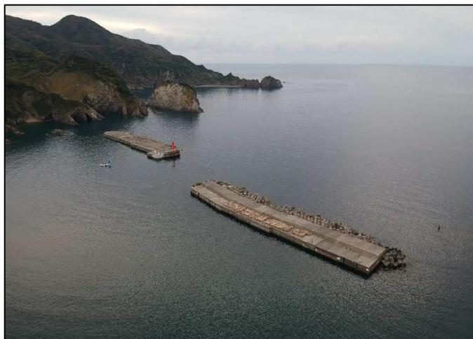
写真管理においてドローンを使用し、ブロック据付後の全体的な見栄えや、防波堤上へ仮置きしたブロックの個数など、従来では分かりにくかった写真を上空から撮影することで一目瞭然となり、現場写真に活用することで表現しやすくなりました。
