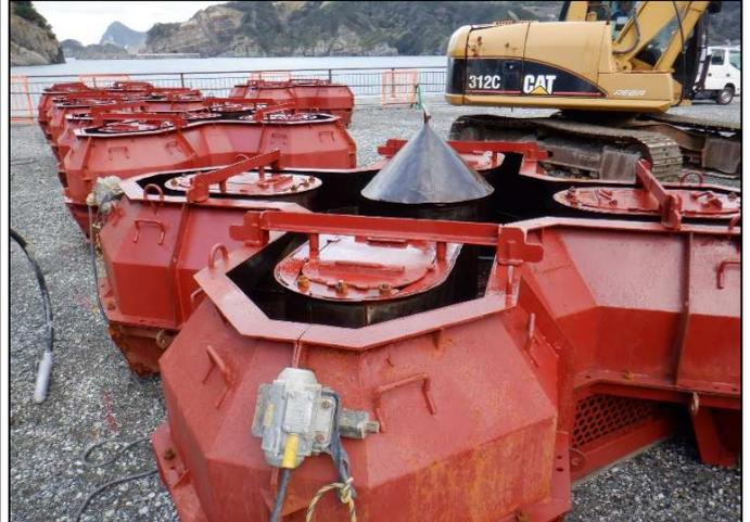
ブロック製作において、コンクリート表面の気泡減少及び美観向上と、緻密なコンクリートに仕上げる為に、コンクリートを打設するブロックの型枠側面に外振バイブレーターを取付け、振動させながらの打設を行いました。打設完了後にはピカコンも併用して製作作業を行った結果、仕上がりの良いブロックを製作することが出来ました。検査時には出来栄の良いブロックだということで、お褒めの言葉をいただくことが出来ました。
