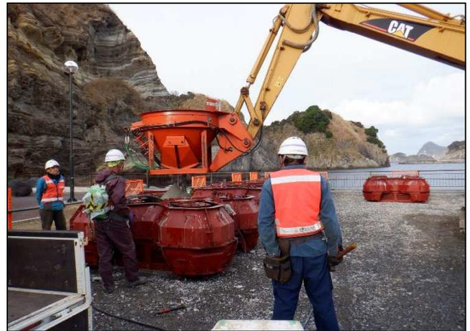
ブロック製作において、型枠上あるいは足場上からの転落災害の要因を無くすため、コンクリート打設用のホッパーをアタッチメントによるバックホウ体型のものとして製作作業を行った結果、常に作業性が良く、冬季の季節風が比較的強く吹くような日でも、ホッパーの振れを止めるような手間も無く、安全且つ効率良くブロック製作を行うことが出来ました。
