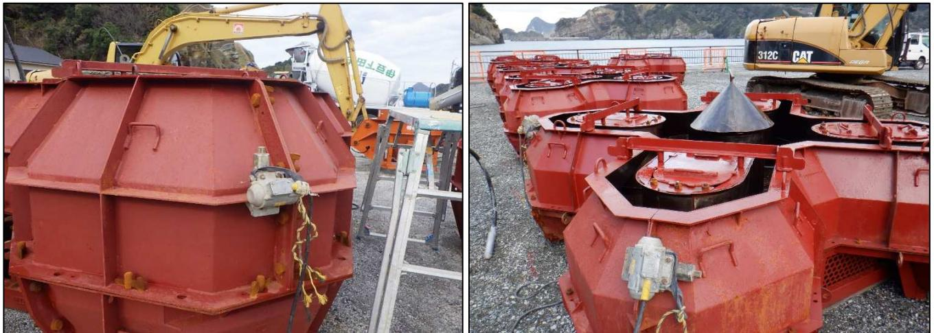
ブロック製作において、コンクリート表面の気泡減少及び美観向上と、緻密なコンクリートに仕上げる為に、コンクリートを打設するブロックの型枠側面に外振バイブレーターを取り付け、振動させながらの打設を行いました。打設完了後にはピカコンも併用して製作作業を行った結果、仕上がりの良いブロックを製作することができました。検査時には出来栄えの良いブロックだということで、お褒めの言葉をいただくことが出来ました。
