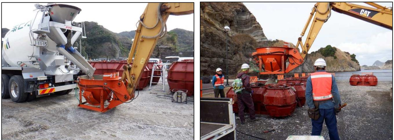
ブロック製作において、型枠上あるいは足場上からの転落災害の要因を無くすため、コンクリート打設用のホッパーをアタッチメントによるバックホウ一体型のものとして製作作業を行った結果、常に作業性が良く、冬季の季節風が比較的強く吹くような日でも、ホッパーの振れを止めるような手間も無く、安全且つ効率良くブロック製作を行うことが出来ました。
