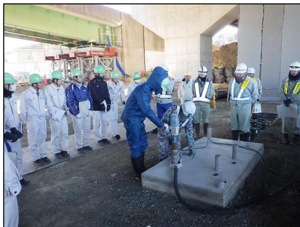
写真：現場にてコア削孔の体験状況
