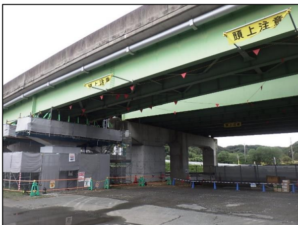
写真：旗付きトラロープ・横断幕設置状況
