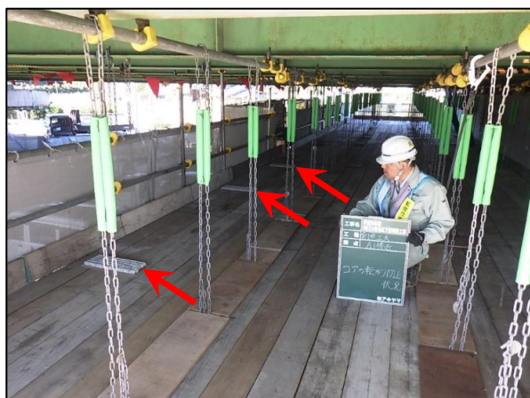
写真：足場作業床 コア仮置き状況
