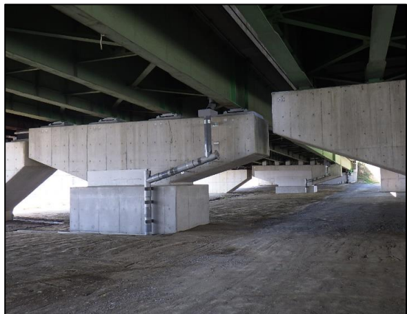
写真：完成写真(P9橋脚～A2橋台)
