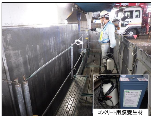
写真：養生材 散布状況
