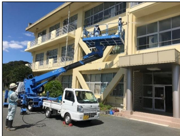
写真：校舎窓の清掃状況
