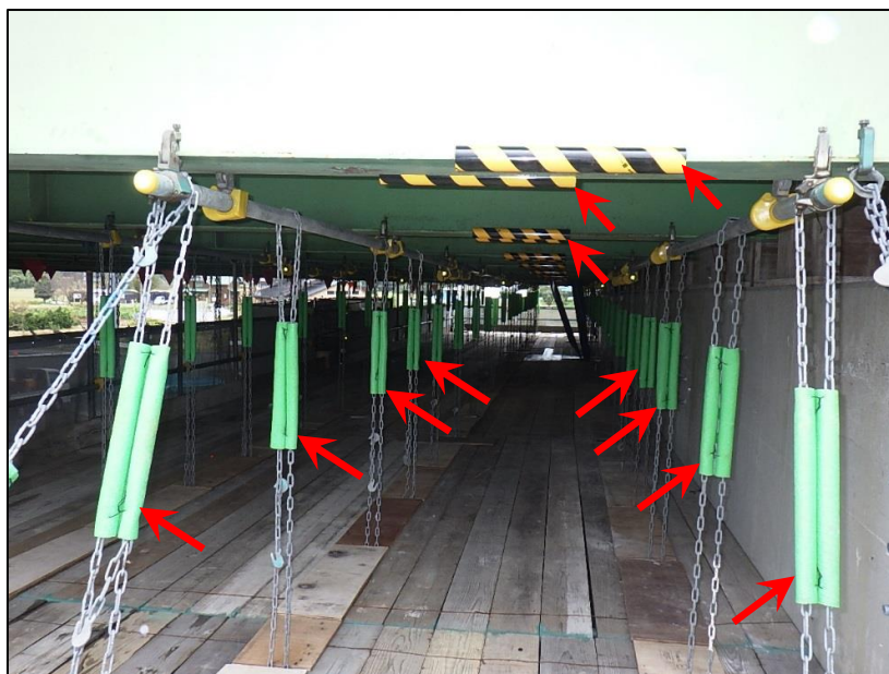
写真：クッション材・トラクッション設置状況
