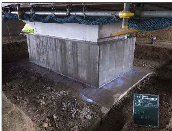
写真：養生材 散布完了
