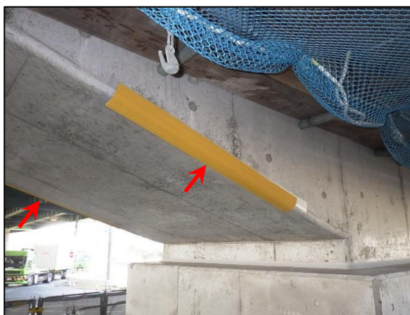
写真：橋脚梁下部 耐候性スポンジ設置状況
