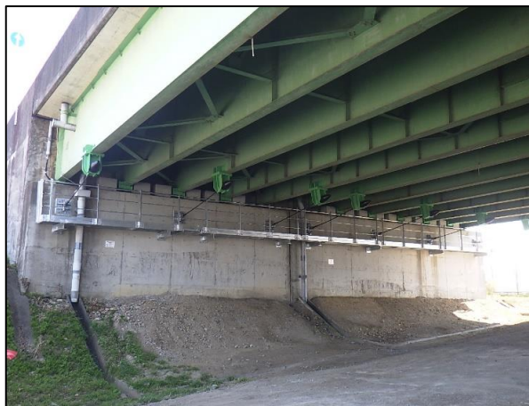
写真：完成写真(A1橋台)
