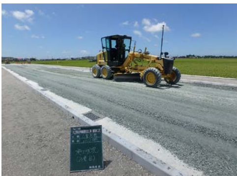
情報化施工によるグレーダーによるマシンコントロール
