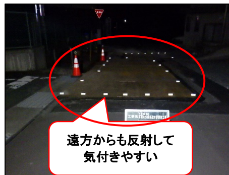
マーカーオメガ設置完了
