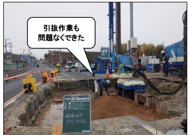
鋼矢板引抜状況
