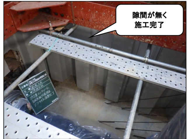
ソフトタイト施工完了
