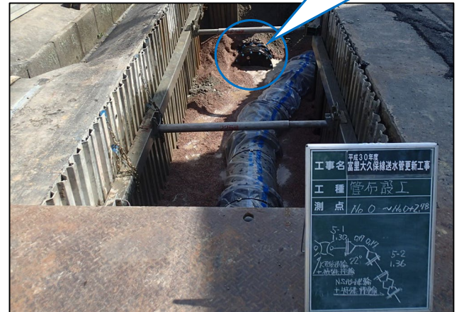
敷鉄板養生前
