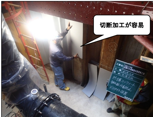
ソフトタイト施工状況
