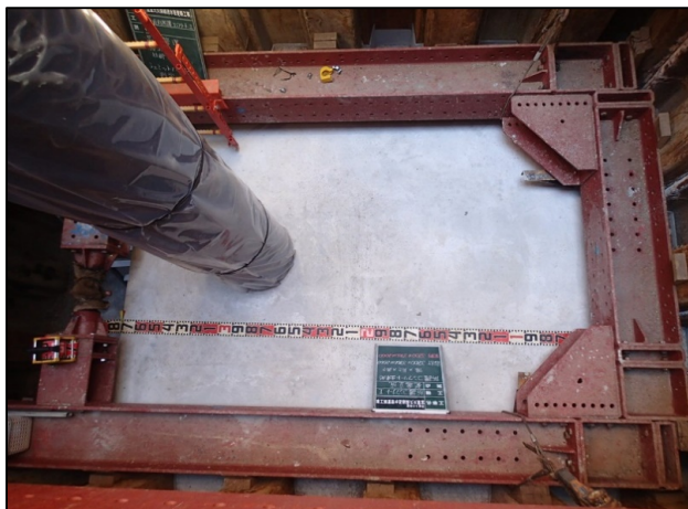
防護コンクリート打設完了
