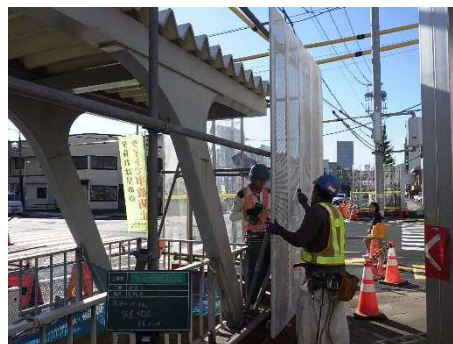
図 3-2 パネル設置状況
