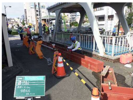
図 3-1 H鋼設置状況
