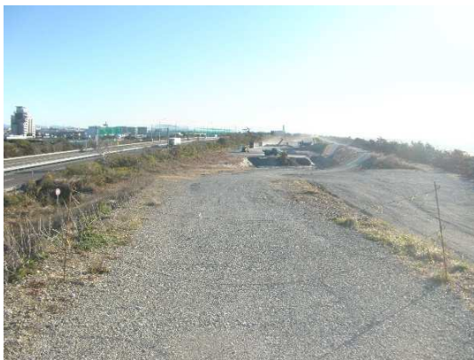
写真-4 工事着手前
