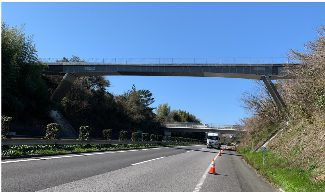
写真-7 完成写真(全景)
