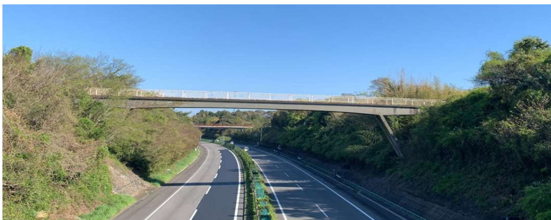
写真-1 庄内水路橋全景
