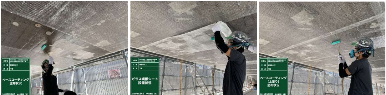
写真-5 施工手順
