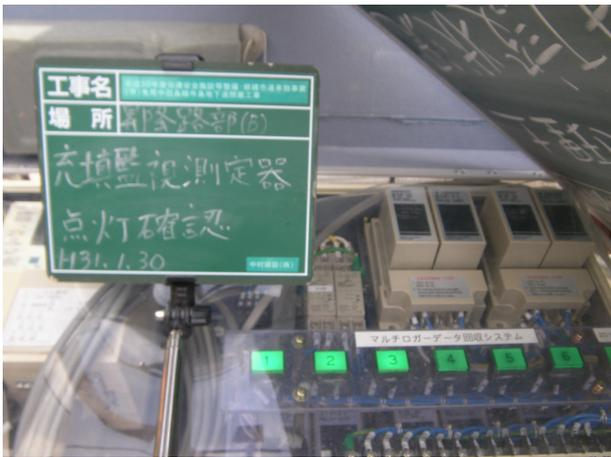
写真-5 充填監視測定器点灯状況
