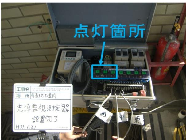
写真-3 充填監視測定器(センサー手元部分)
