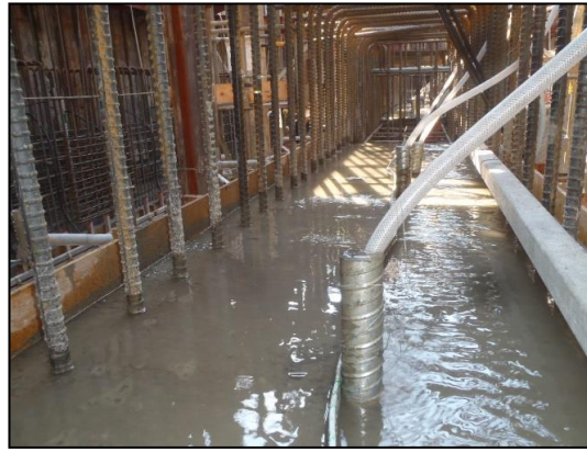
写真-7 鉛直パイプクーリング実施状況
